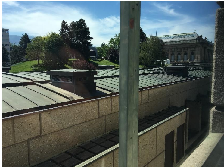
Figure 3 : Extraction d'air en toiture Bâtiment G
